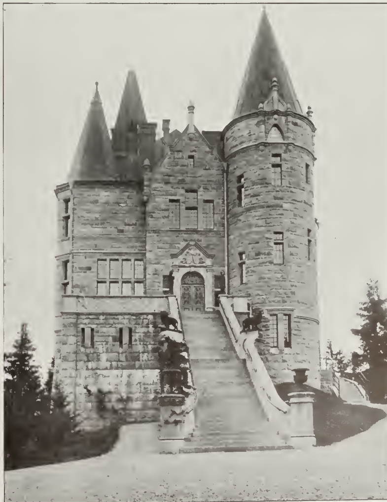
Teleborgs slott, södra fasaden.
